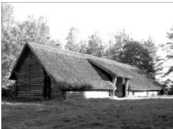
Klojimas su vienu įvažiavimu iš šono Užusienio k. Pasvalio r. Ties durimis paaukštinotas stogas (LLBM)
