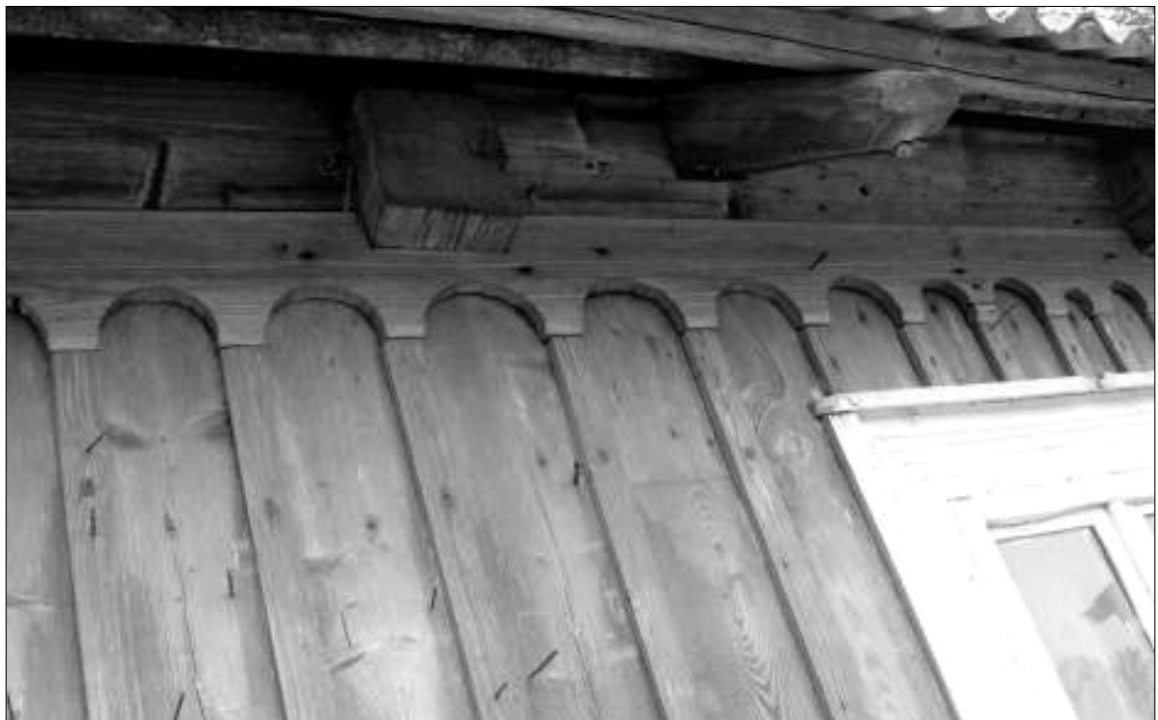
Sienos apkalimas horizontaliomis (viršuje) ir vertikaliomis (apačioje) lentomis. Tradicinis sienos apkalimas vertikaliomis lentomis su juostomis (dengiančiomis lentų sudūrimus) viršuje užbaigiamas horizontalia išpjaustinėta lenta (LLBM)
