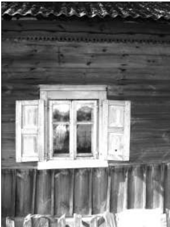
Sienos apkalimas vertikaliomis (iki lango apačios) ir horizontaliomis lentomis (LLBM)
