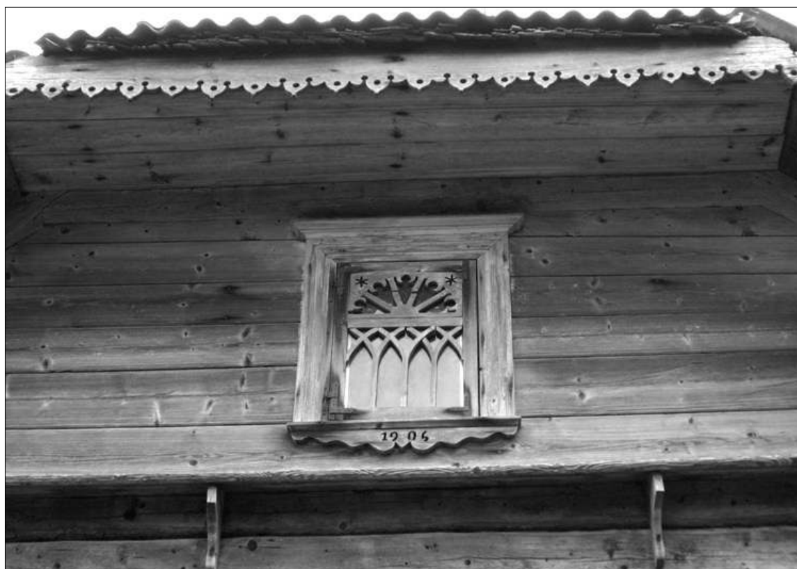
Skliauto langelis su išpjaustyta namo statybos data Lažų k. Kėdainių r. (R.Bertašiūtės 2006 m. nuotr.)
