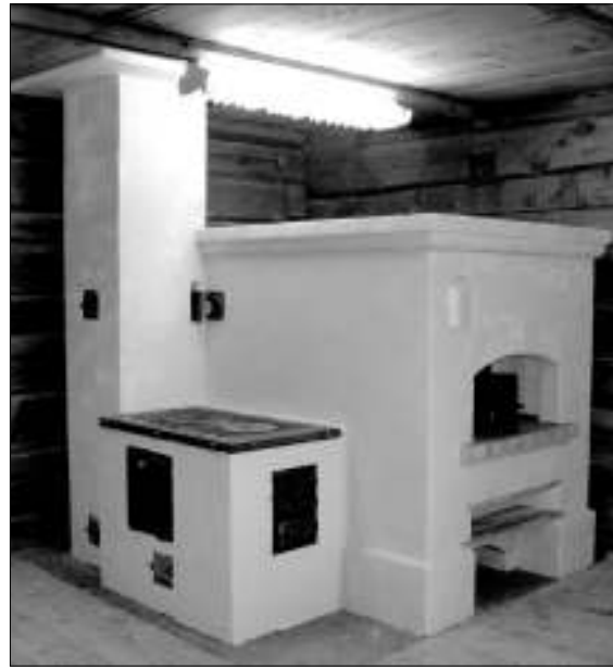
Duonkepė krosnis su kaminu ir pristatyta virykle Mičiūnų k. Kupiškio r. (R.Bertašiūtės 2007 m. nuotr.)
