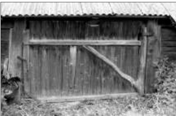
Daržinės virpstinės konstrukcijos durys Karališkių k. Širvintų r. (R.Bertasiūtės 2007 m. nuotr.)
