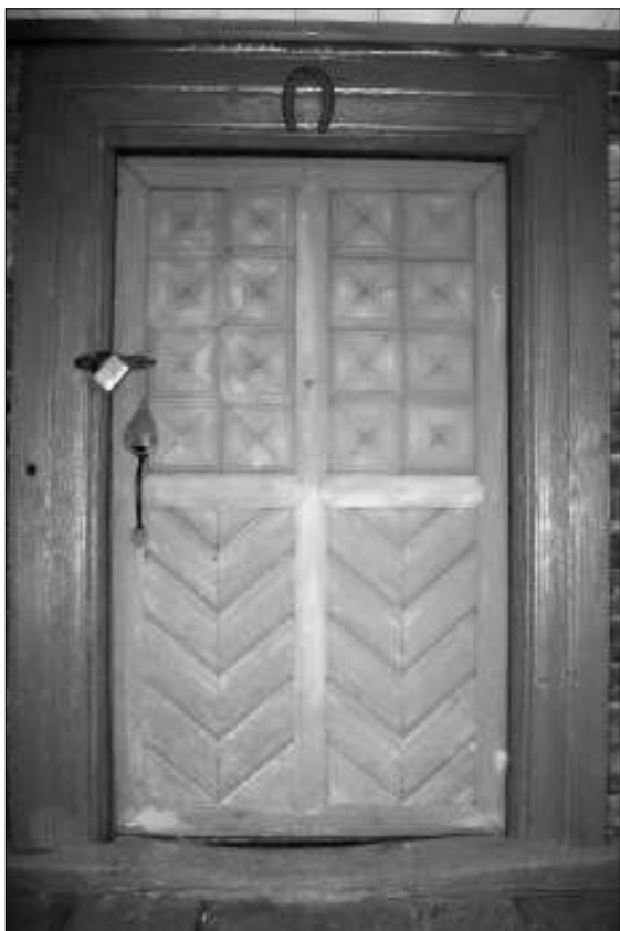
Originalaus piešinio dvigubos gryčios durys Gryčios įsprūdinės konstrukcijos durys. Virš durų nedidelis langelis priemenei apšviesti
