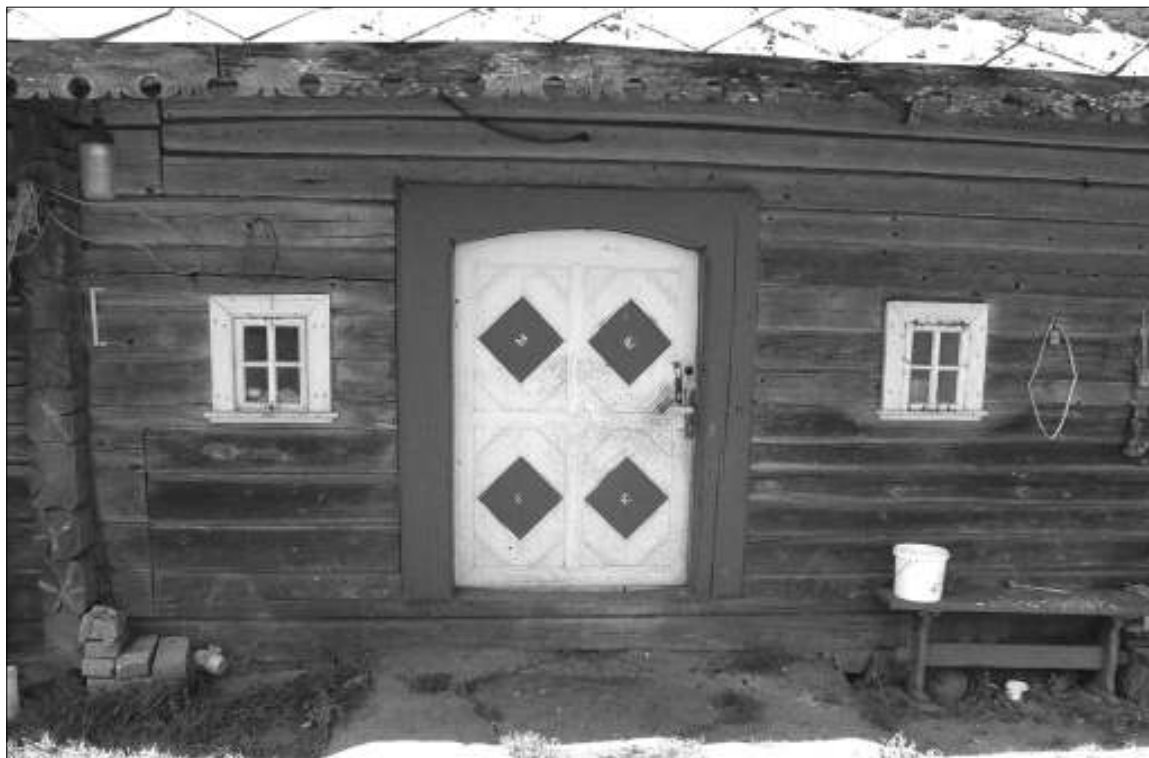
Vienvėrės dvigubos gryčios durys, puoštos dekoratyviu apkalu. Abipus durų – maži priemenės langeliai Varžų k. Ukmergės r. (KPD)
