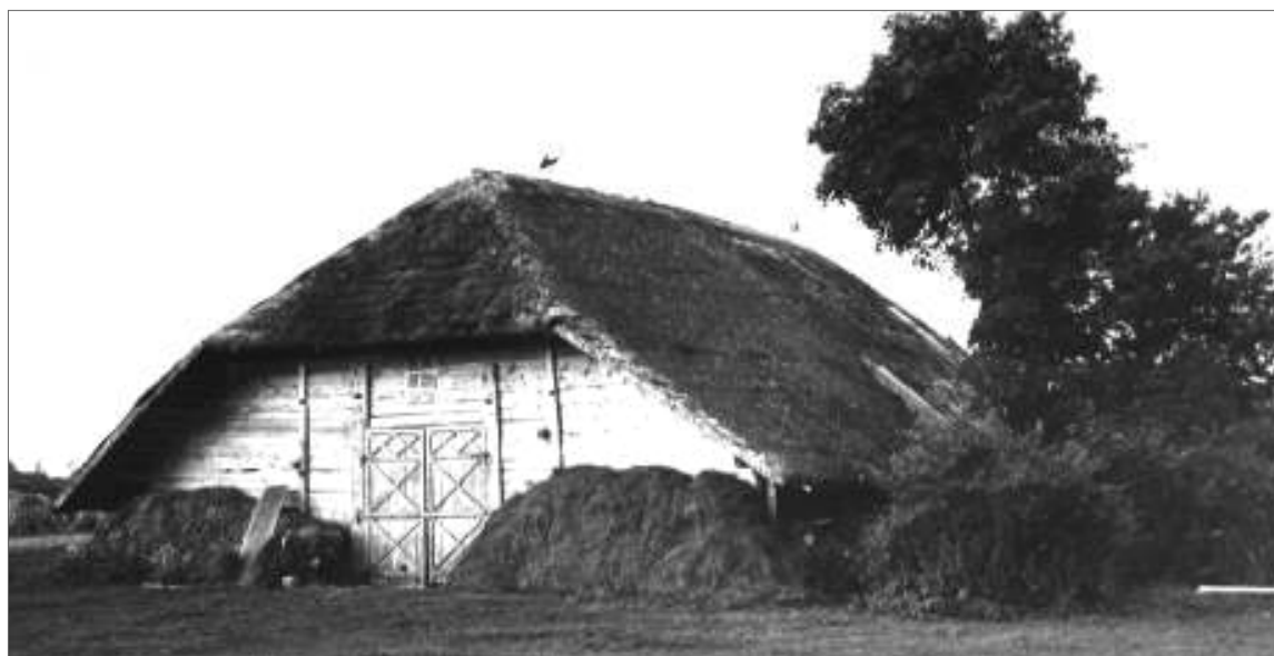
Pėdinės konstrukcijos klojimas su pusskliautiniu stogu Panevėžio r. (LLBM)
