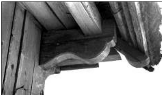
Paplatinta pastogė. Sija ir gegnių galai dailiai profiliuoti (LLBM)
