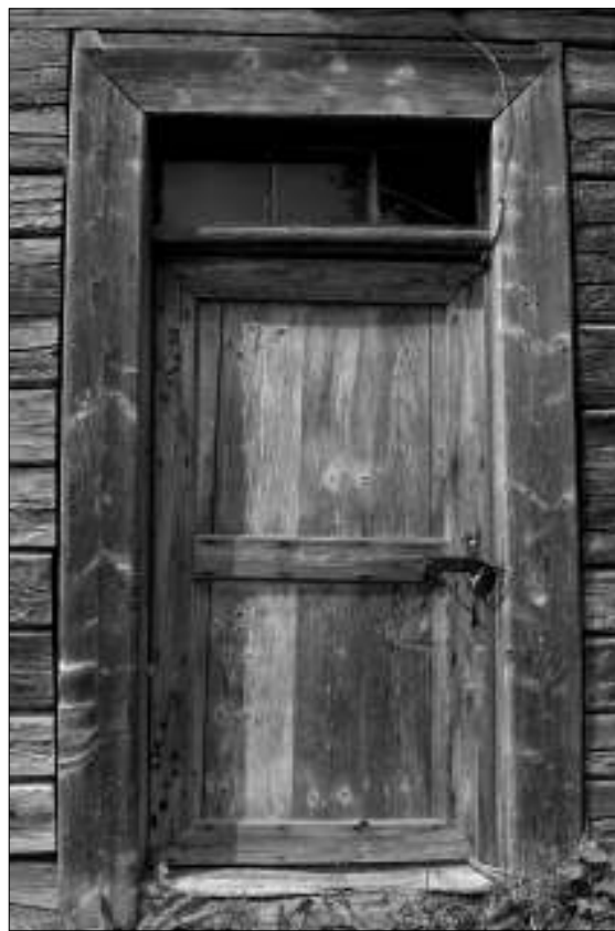
Originalaus piešinio dvigubos gryčios durys Gryčios įsprūdinės konstrukcijos durys. Virš durų nedidelis langelis priemenei apšviesti
